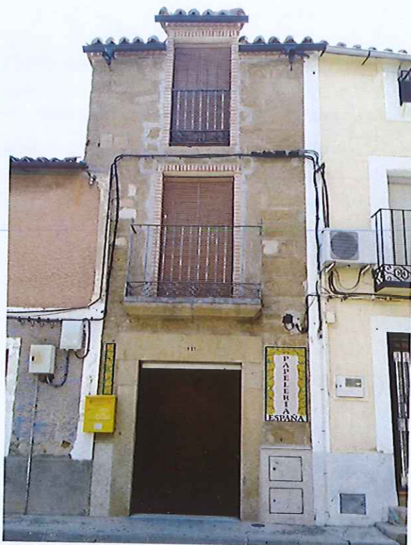
Edificio de 1921, en el que hoy está el Correo y la tienda de Andrés y Margarita.
